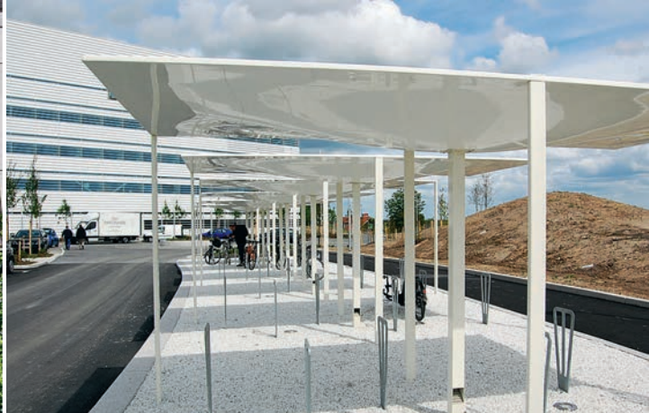
Snøhetta har designat de vågformade taken till cykelställen, som är framtagna av Nola. Foto: Snøhetta.
